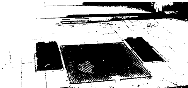
Fig. 24. - Bouche d'incendie de 100 mm « jumelées ».
